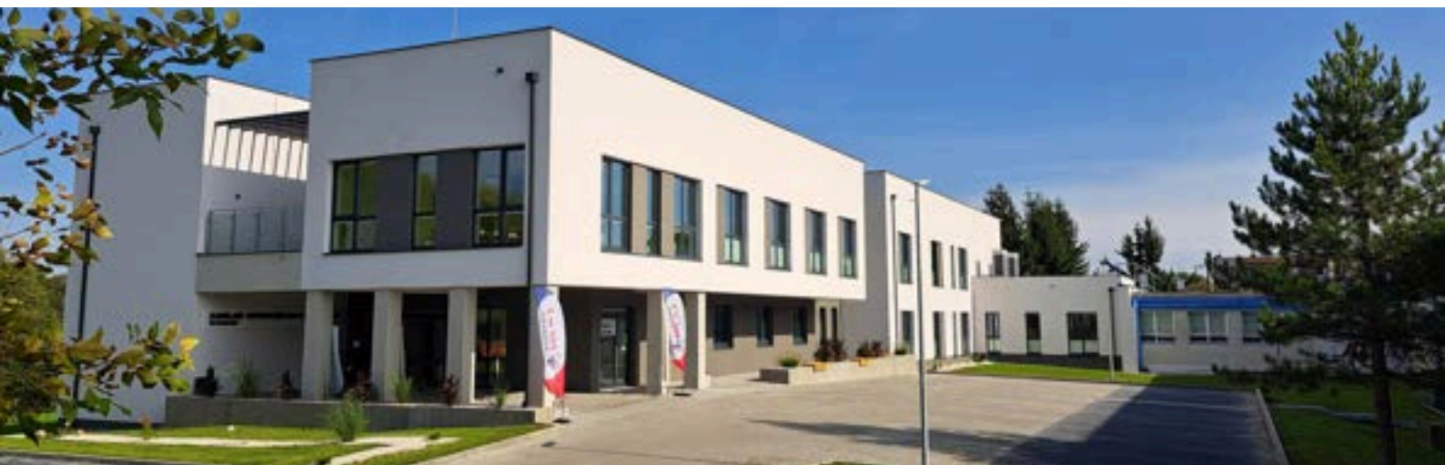
Fot. M.Gwizdak, Zakład Opiekuńczo-Lecznicy w Dynowie
