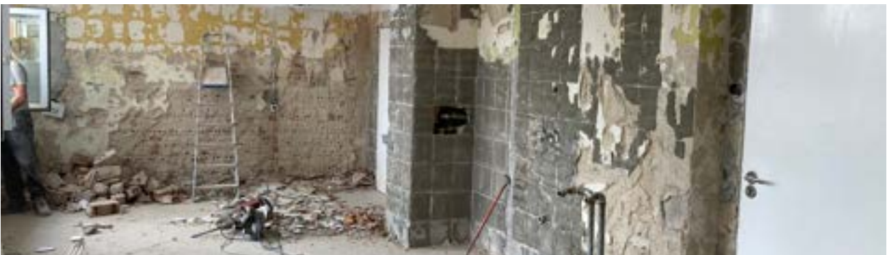
Pracownia gastrokopii i kolonoskopii w trakcie remontu. Fot. M. Stanisławczyk
